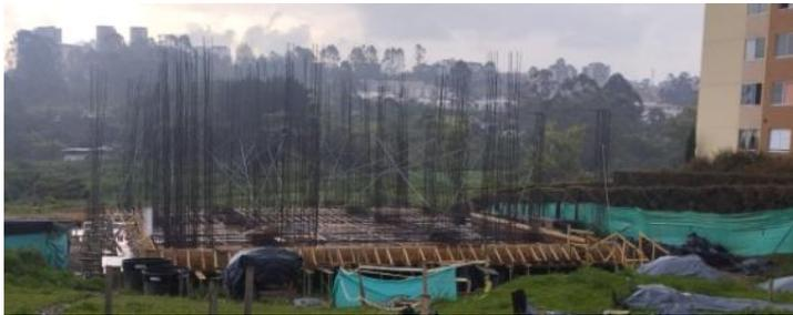
Luego de superada la intervención en el suelo y de haber ejecutado la construcción de las fundaciones del edificio, el proyecto Remanso de Oriente se encamina a la construcción de la estructura del edificio, encontrándonos en el vaciado de las losas.
