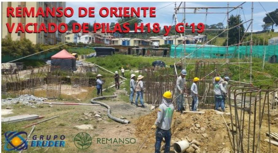
Se finalizó el vaciado de las últimas pilas de cimentación faltantes, lo cual nos permite seguir la construcción de las losas de cimentación.
